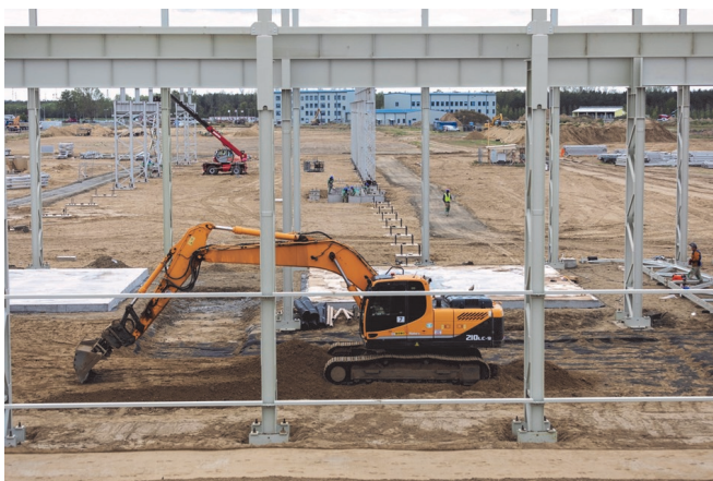
Dolgoznak a munkagépek az építési-szerelési bázison
