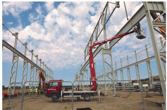
Épülnek az acél- és betonacél-összeszerelő komplexum épületei
