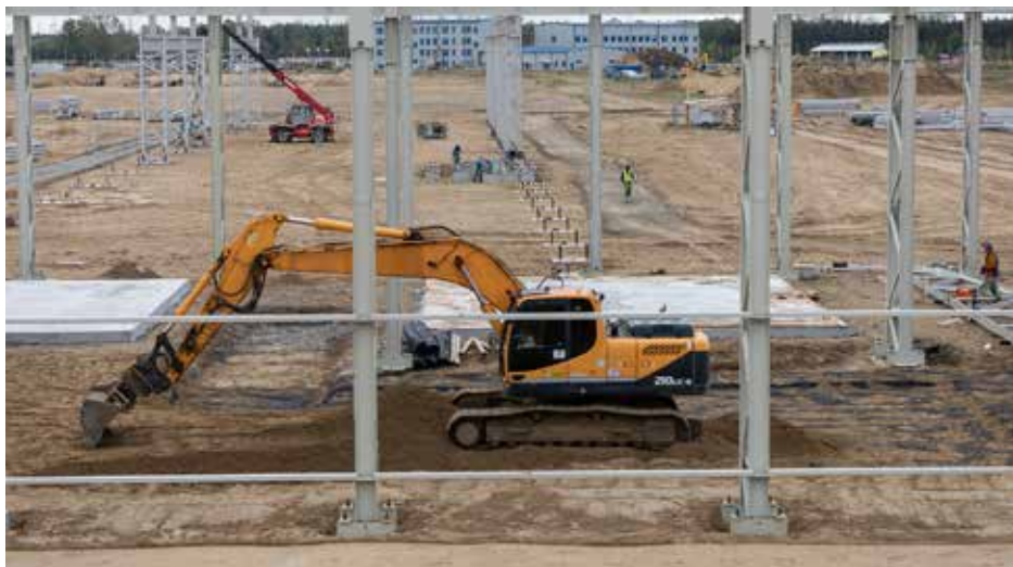
Dolgoznak a munkagépek az építési-szerelési bázison
