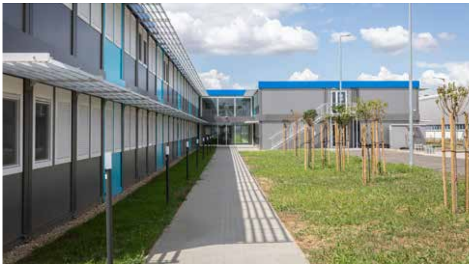
Az Erőmű-beruházási Központ korszerű konténerépülete
