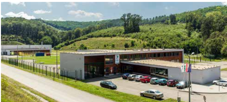
A Nemzeti Radioaktívhulladék-tároló (NRHT) telephelye Bátaapátiban
