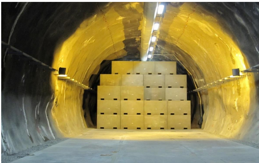
3. ábra: Vasbeton konténerok végleges elhelyezése az I-K1 tárolókamrában
