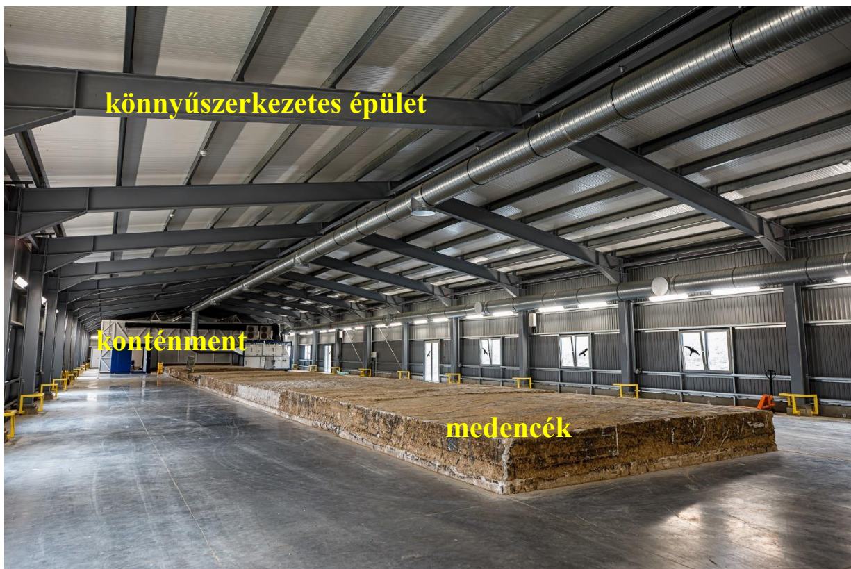
2. ábra: Az RHFT I. medencesora fölé telepített könnyűszerkezetes épület és konténment
