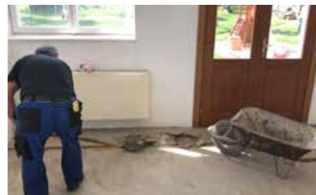
A padlózat törmelékének elszállítása
