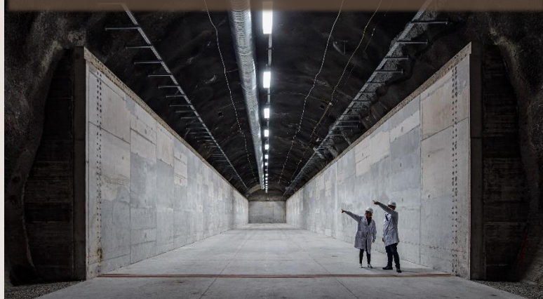
A második kamrában kialakított vasbeton medence készen áll az új kompakt hulladéksomagok fogadására
